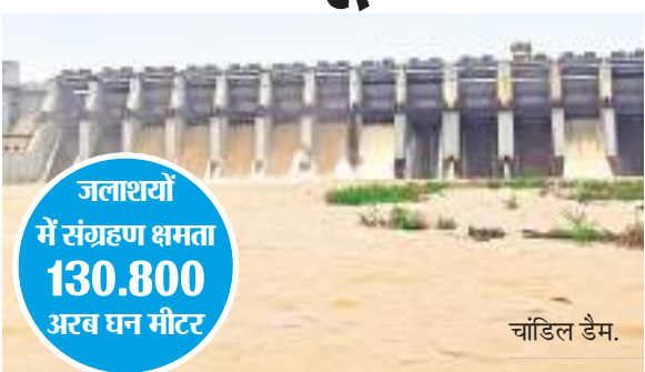
जलाशयों में संग्रहण क्षमता 130.800 अरब घन मीटर चांडिल डैम.
