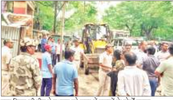
नगर निगम की टीम ने बुधवार को शहर में दुकानों के बोर्डों हटाने का काम किया।
