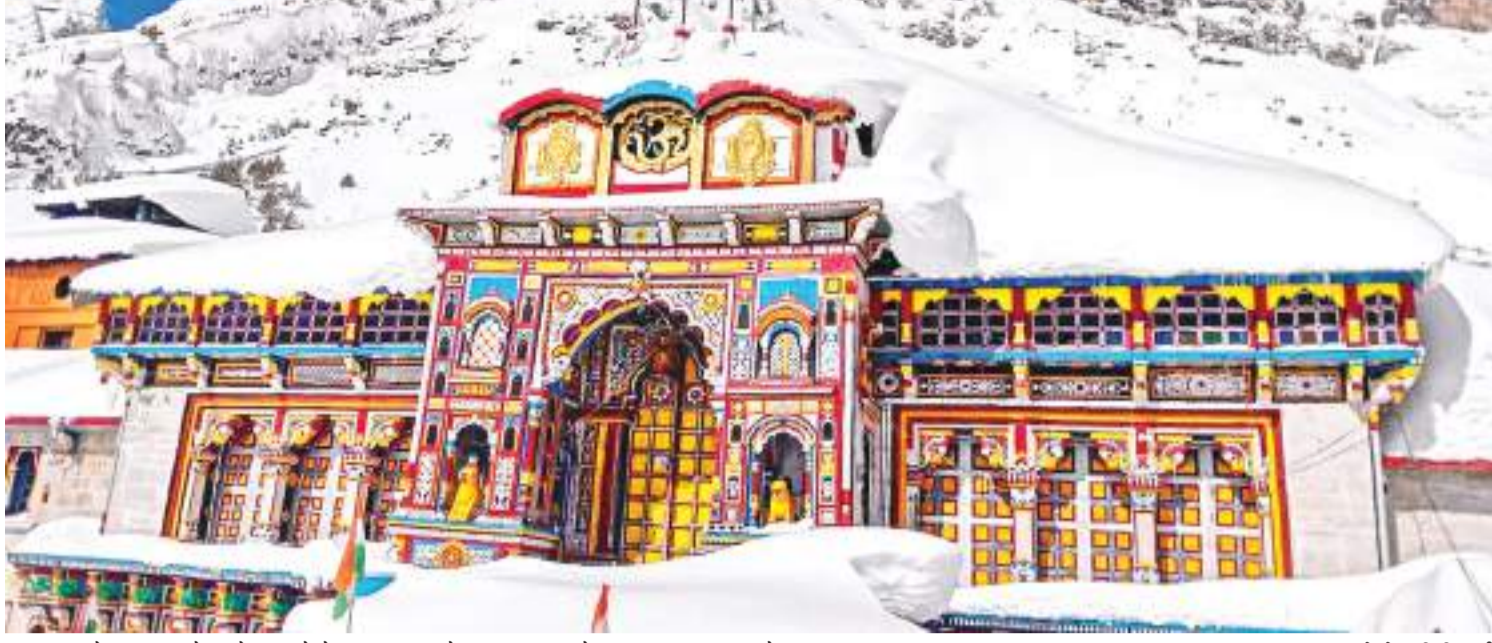
मंगलवार को उत्तराखंड के चमोली जिले में भारी बर्फबारी के बाद छह फीट से अधिक बर्फ की परत से बदीनाथ धाम ढंका गया.
